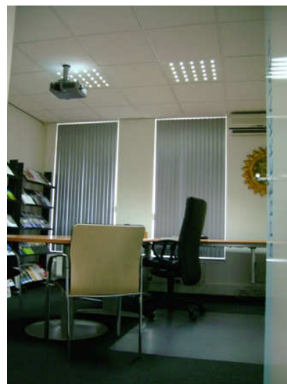
Na installatie 60% energie besparing
