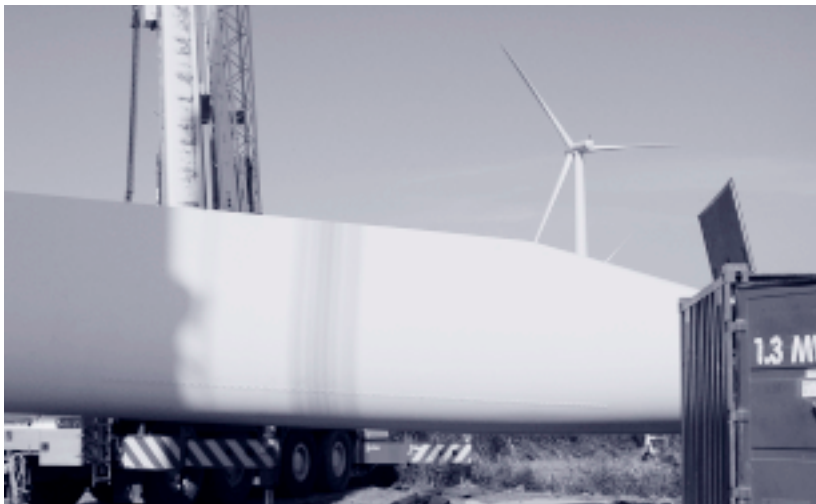
Foto1: De bouw van een windturbine
